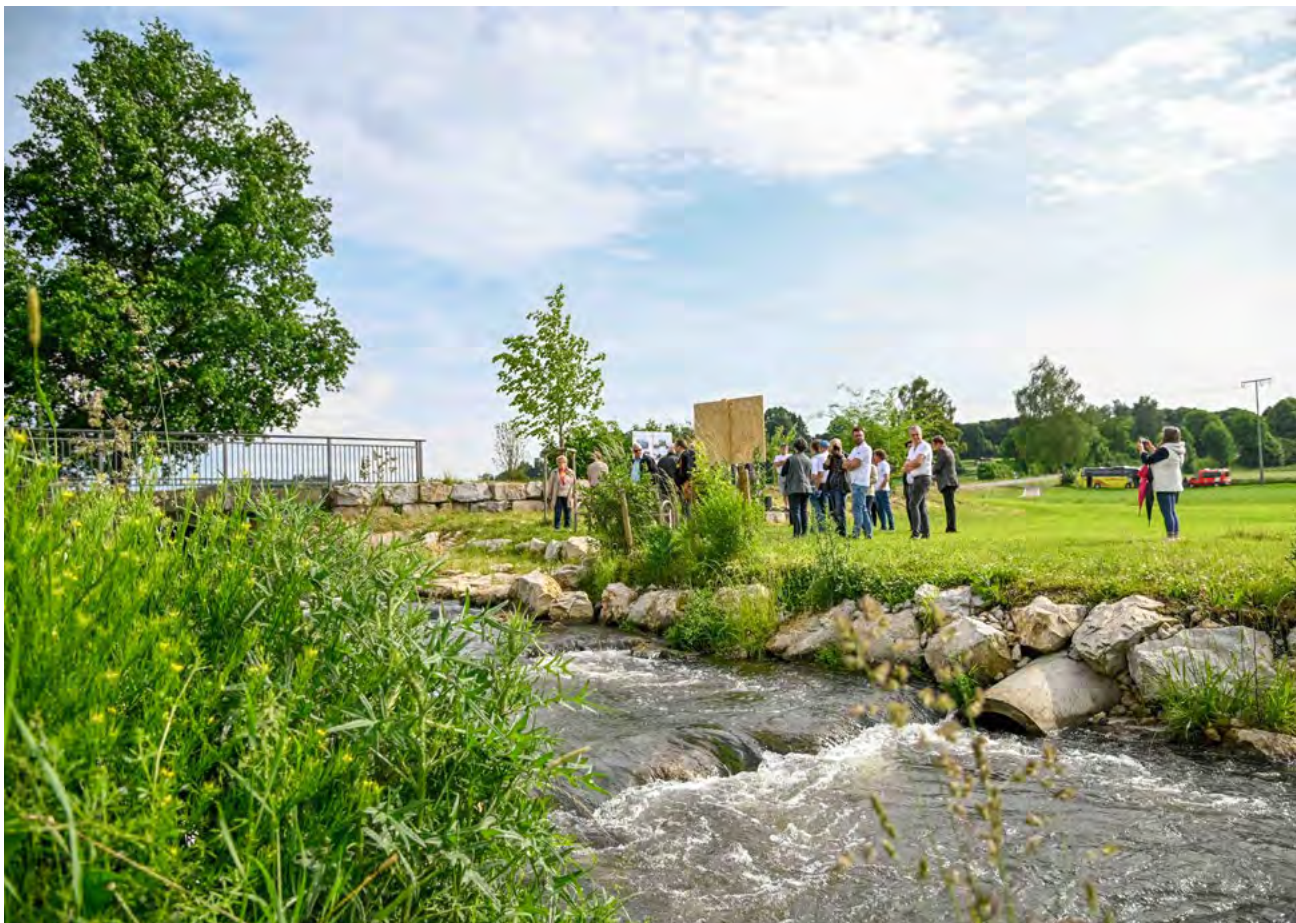
Positiv hervorzuheben ist die neu errichtete Fischtreppe im Schwarzbach, die sowohl ökologisch wertvoll als auch hochwasserschutzrelevant ist.
