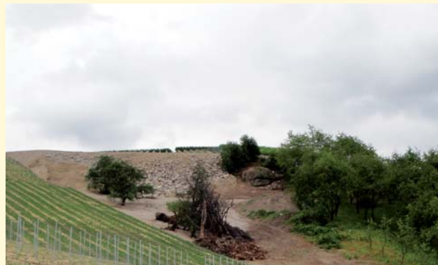
Steinschüttung, Felsfreistellung und Totholzanlage
