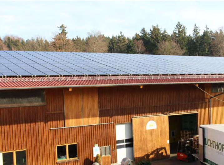
Die Kühlung ist energieintensiv. Um möglichst energiesparend zu wirtschaften, haben viele Betriebe Solaranlagen auf dem Kühllager installiert. Einige nutzen auch die Abwärme aus der Kühlung der Lagerräume für die Beheizung der Sortier- und Wohnräume.
