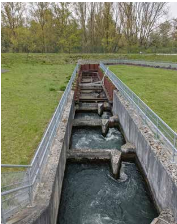
Abb. 5.9: Um die Durchgängigkeit von Wasserkraftanlagen für Fische zu verbessern, werden diese mit Fischwanderhilfen ausgestattet. Bisher besitzt jedoch nur ein geringer Teil der Anlagen in Baden-Württemberg solche Systeme.
