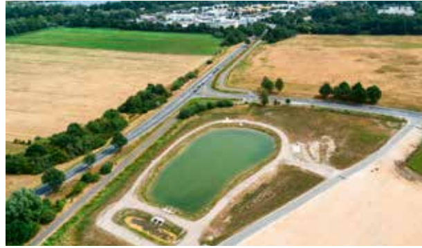
Abb. 5.15: Regenrückhaltebecken können verhindern, dass im Sommer bei Starkregenereignissen erwärmtes Wasser in die Fließgewässer gelangt. Viele der heute bereits vorhandenen Becken müssen aber für zukünftige Extremwettersituationen angepasst werden.
