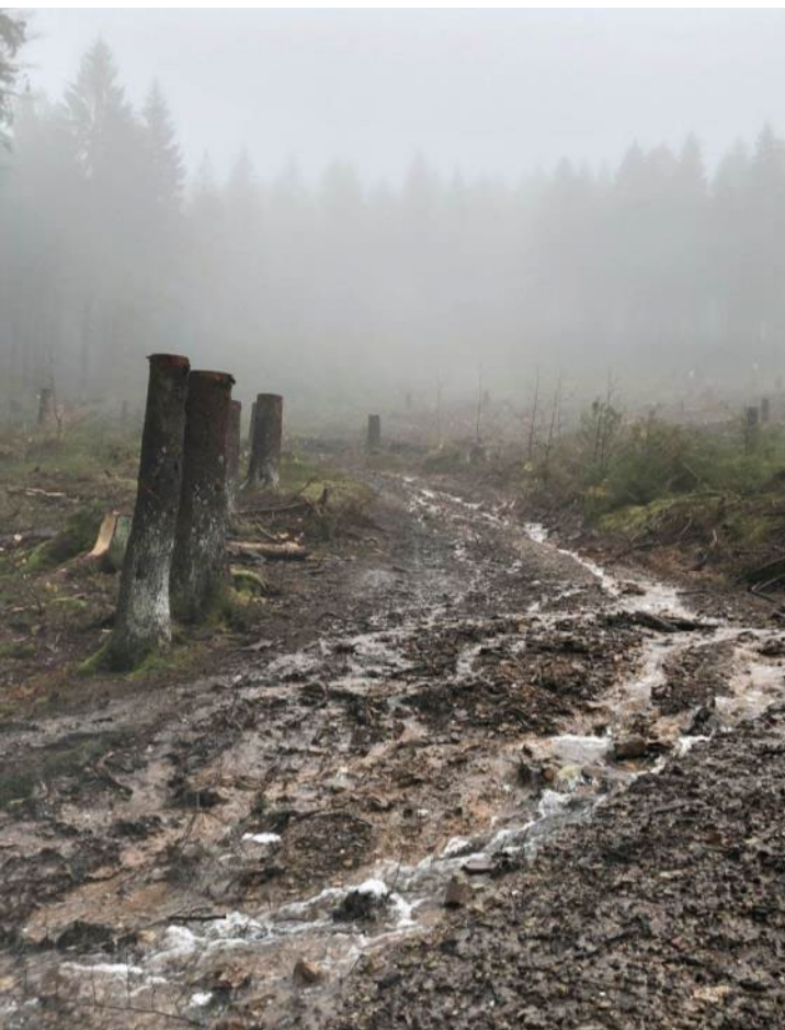
Abb. 25: Erosionsschäden an einem Waldweg entlang einer Kahlfläche nach einem Starkregenergebnis (Foto: H. Puhlmann).
