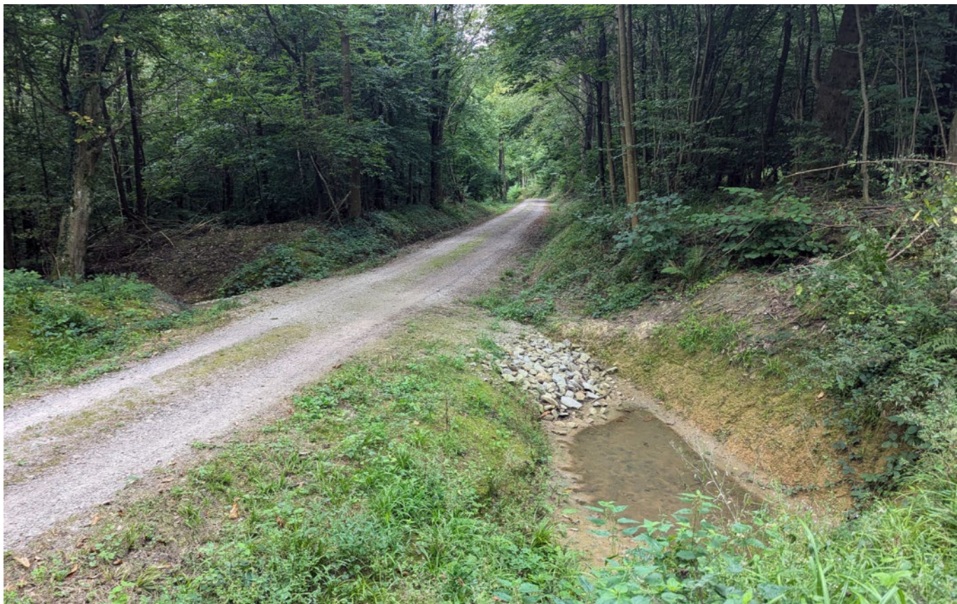
Abb. 28: Rigole mit Sedimentationsbecken auf der Bergseite (Foto: H. Puhlmann).
