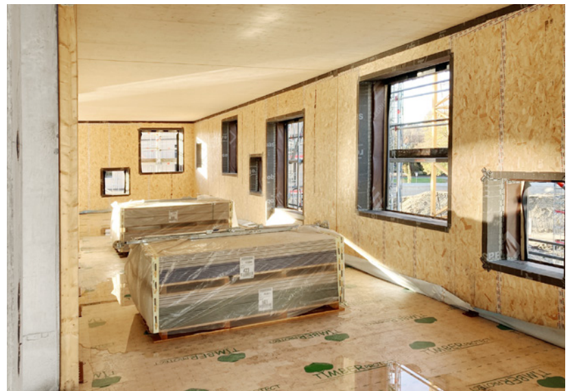
Abb. 8.1.R.3: Tafелеlemente auf der Baustelle
