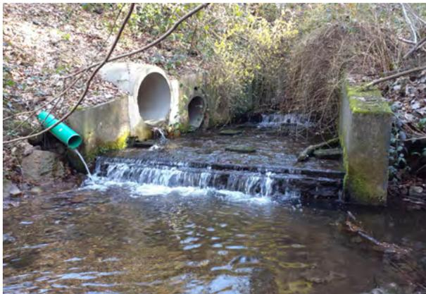
**Abbildung 16:** Beispiel für eine Querverbauung: Abstürze hinter Rohren oder Schwellen können von vielen Bachorganismen nicht überwunden werden. So stellt für Groppen beispielsweise ein Absturz über 10 cm Höhe bereits eine Wanderungsbarriere dar.
