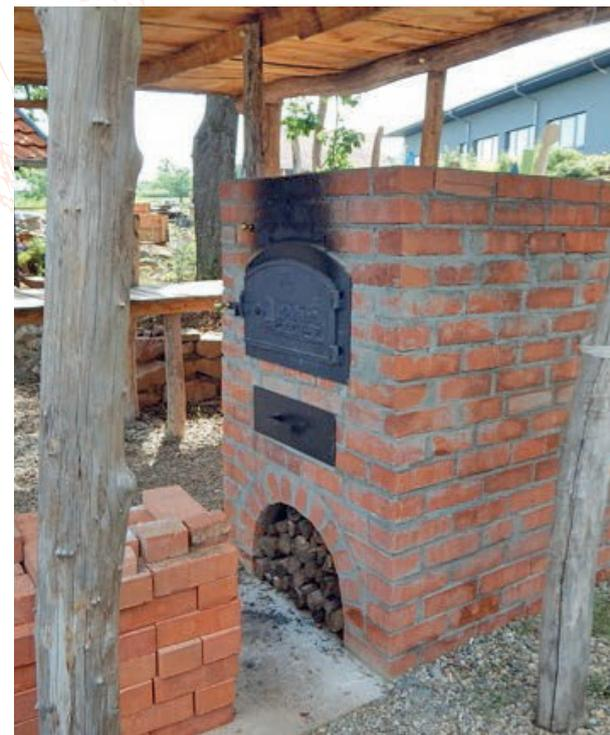
Abb. 104: Ein selbst gebauter Backofen aus Backsteinen
